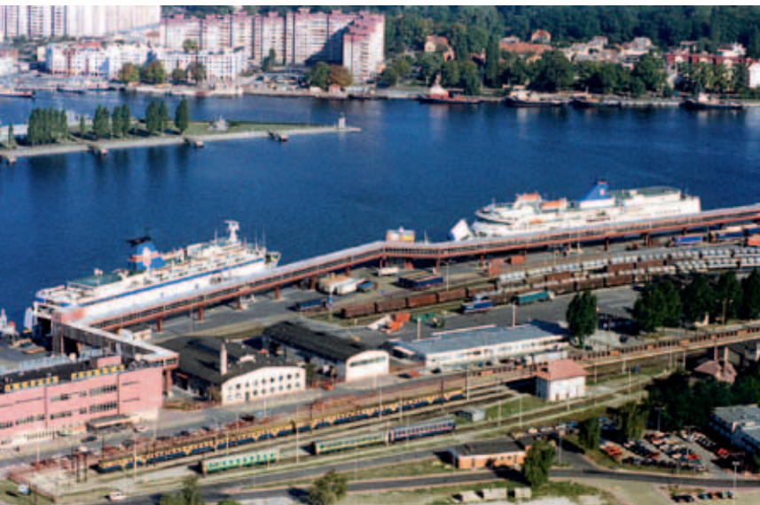
W LUTYM 2000 R. PŻB PRZY WSPARCIU SKARBU PAŃSTWA ZAKOŃCZYŁA BUDOWĘ BAZY PROMÓW MORSKICH W ŚWINOUJŚCIU. BUDOWA TRWAŁA 12 LAT, KOSZTOWAŁA OKOŁO 40 MLN EUR. FOT. M. CZASNOJĆ
