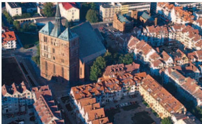
ZNACZNA CZĘŚĆ MIESZKAŃ DLA PRACOWNIKÓW PŻB POWSTAŁA W KOŁOBZIEGU W RAMACH BUDOWY STARÓWKI · FOT. R. GAUER
