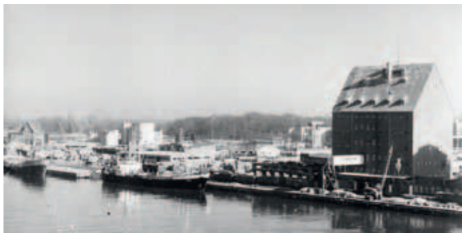
PORT KOŁOBRZESKI W 1975 · OBOK ELEWATORA WIDĄĆ FUNDAMENTY PRZYSZŁEGO BIUROWCA PŻB · FOT. ARCHIWUM PŻB
